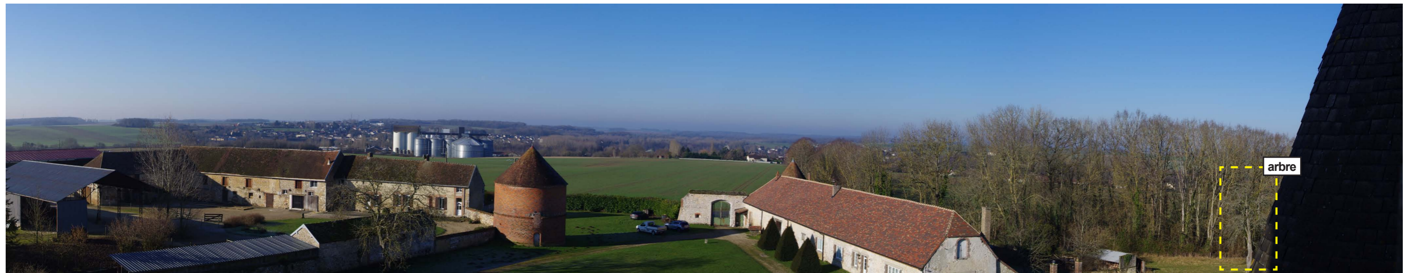
Perceptions depuis les combles de la tour (vue PE004)
