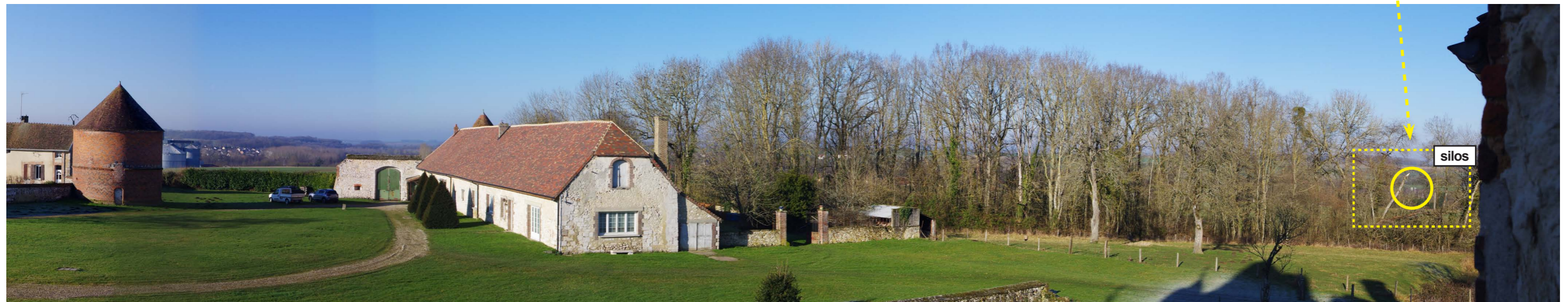
Perceptions depuis le corridor de l'aile Nord (vue PE006) et localisation de silos de Vivier
