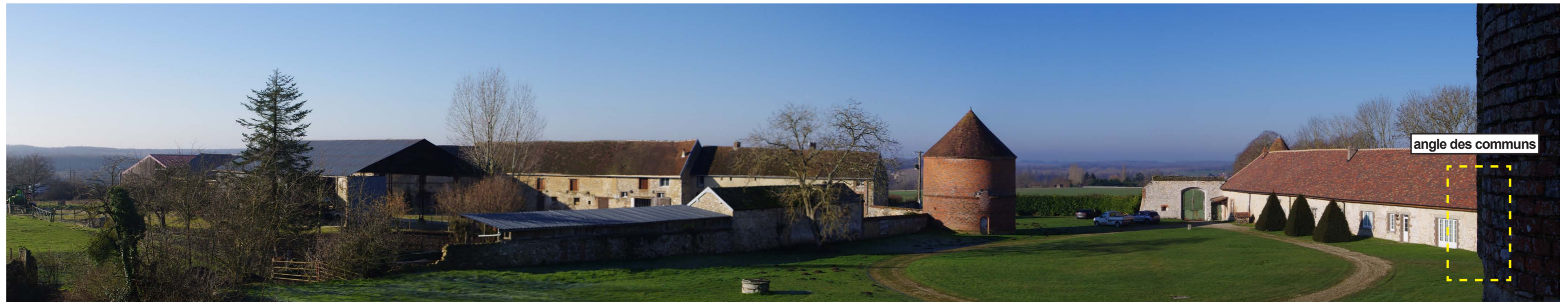
Perceptions depuis le corridor de l'aile Sud (PE003)
